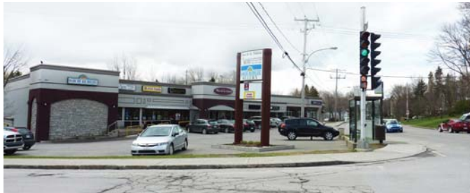
Photo 36 : Implantation oblique et stationnement en façade
