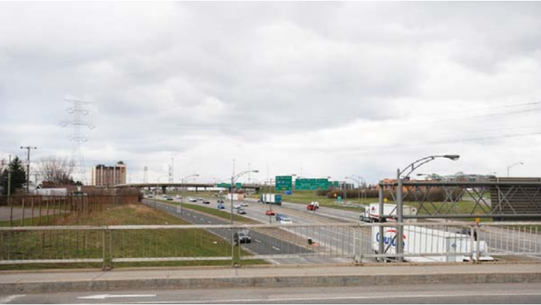
Photo 44 : Axes autoroutiers en contrebas du chemin Saint-Louis
