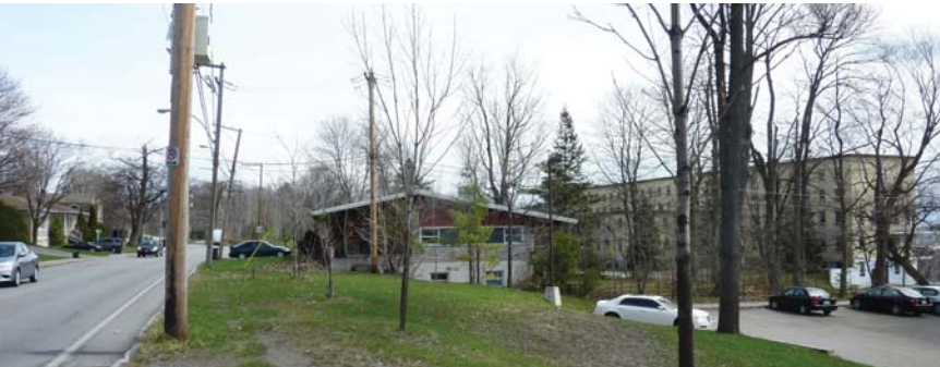
Photo 25 : Bâti résidentiel incohérent
