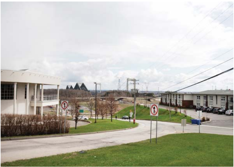
Photo 4 : Les ponts depuis le chemin Saint-Louis
