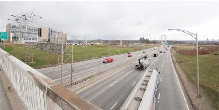
Photo 45 : Axes autoroutiers en contrebas du chemin Saint-Louis
