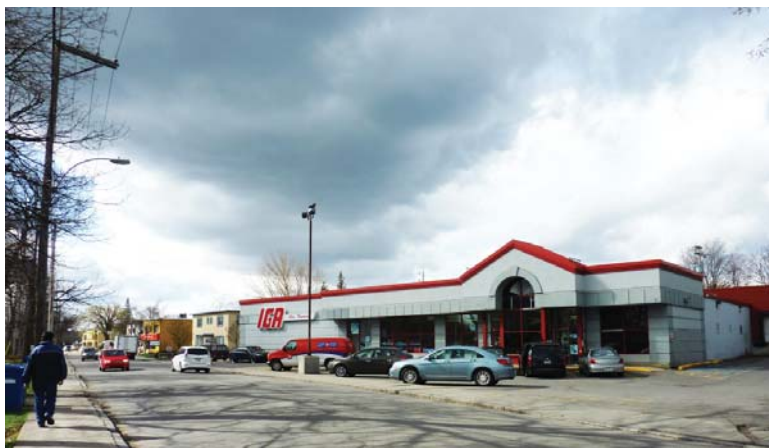
Photo 14 : Commerce déstructurant avec stationnement en façade
